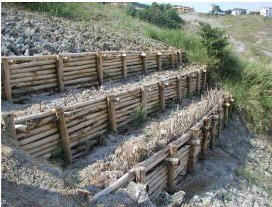
La funzione stabilizzante della struttura è immediata e garantita nella prima fase dagli elementi lignei e lapidei la cui funzionalità viene sostituita da quella delle piante che crescendo fanno migliorare le caratteristiche geomeccaniche del terreno e fanno sviluppare un'ottima copertura vegetale.
